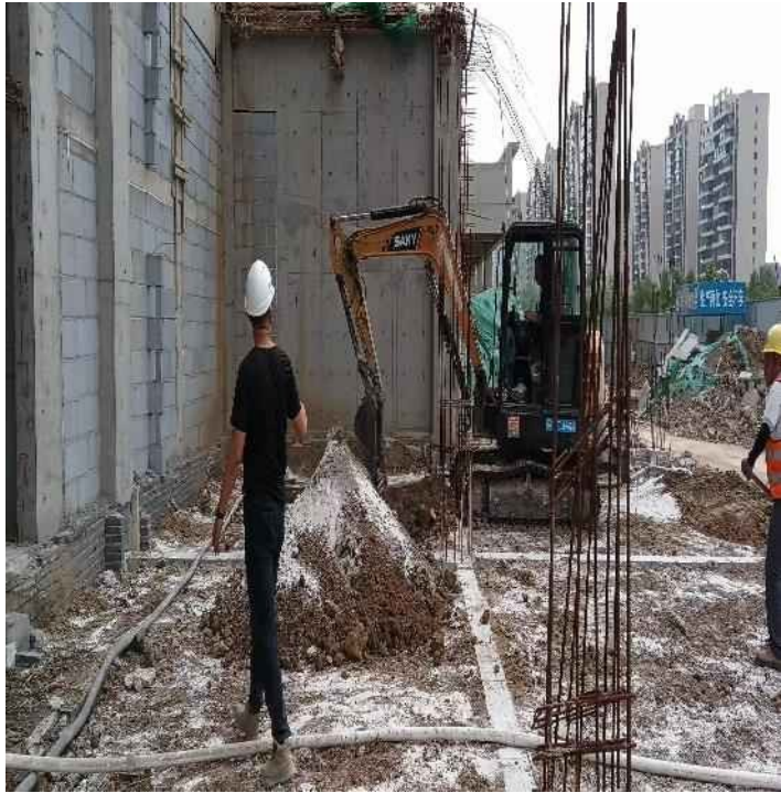
三七灰土回填并旁站
